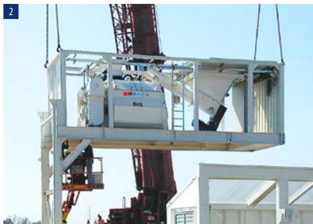
2 Монтаж стойки модуля смесителя
