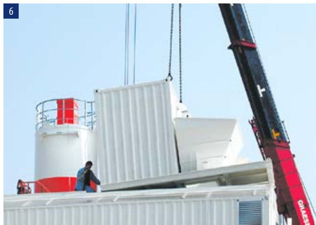
6 Установка модуля весов
