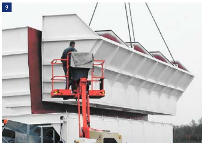
9 Установка бункера-дозатора для инертных материалов (состоит из трёх транспортируемых блоков)
