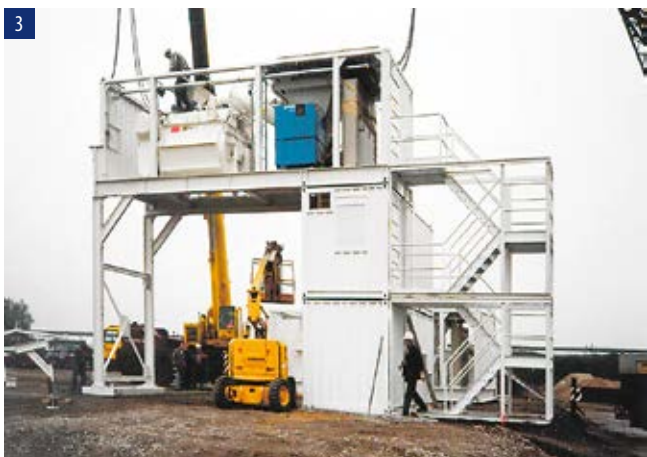
3 Размещение модуля смесителя на базе контейнера. Фиксация стандартными элементами крепления контейнеров
