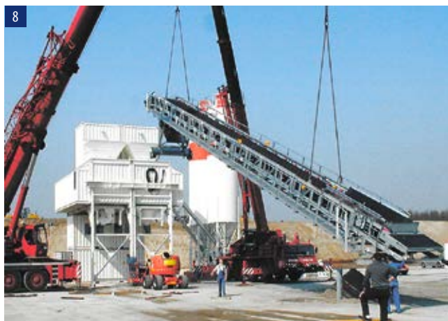
8 Установка наклонного конвейера
