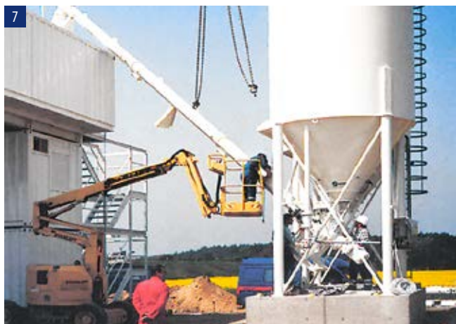
7 Установка бункера для цемента и навешивание шнекового транспортера
