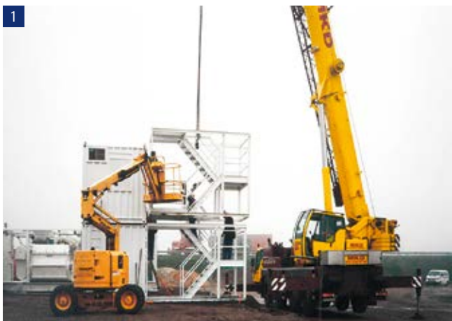
1 Установка контейнера с химикатами и контейнера управления на выровненной земляной площадке
